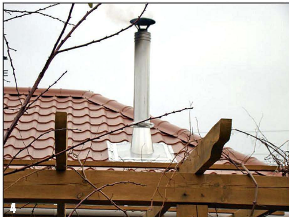
4 ...и крышу установлены разделки.
