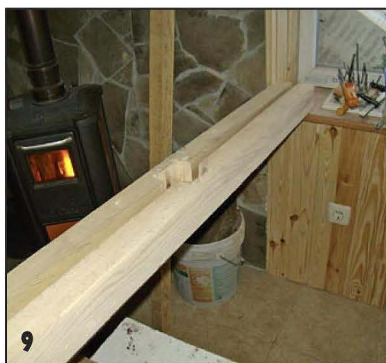
9 Для фальшбалок использованы бруски 50x50 мм.
