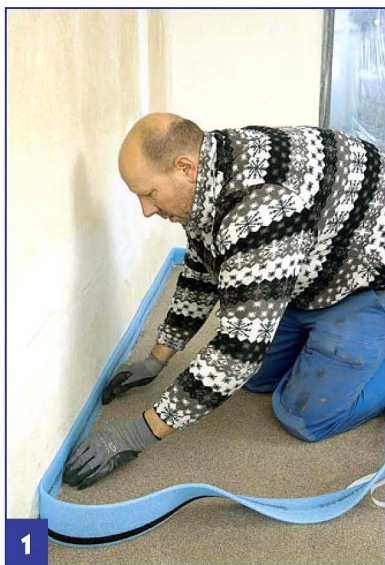
1 Демпферную ленту крепят к стенам по всему периметру помещения.
