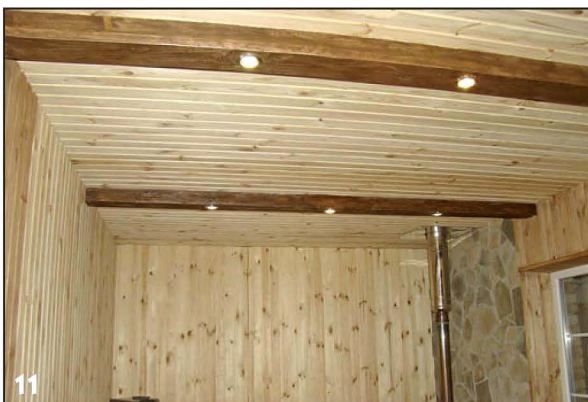
10 Фальшбалки со встроенными светильниками закреплены на потолке и выделены цветом.
