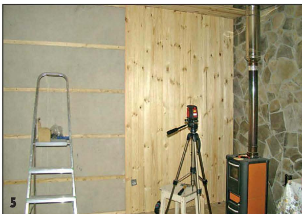
5 Обшивка стен вагонкой. Контролировать вертикальность досок помогает лазерный нивелир.
