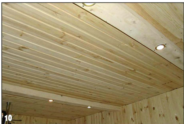
10 Фальшбалки со встроенными светильниками закреплены на потолке и выделены цветом.
