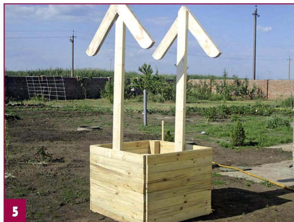
5 Стойки со стропилами прикрутил с тыльной стороны к доскам обшивки короба.
