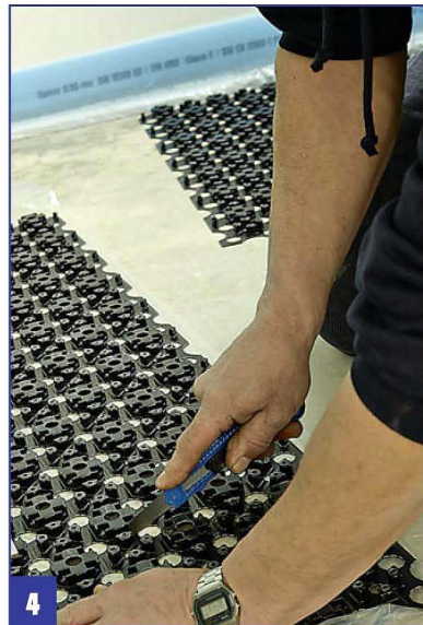
4 При необходимости подогнать панель по размеру, её обрезают ножом.
